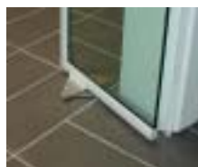
1. Montage på bef.golv
